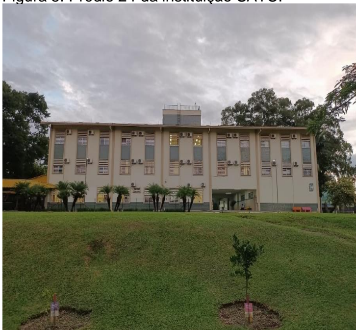
Figura 5: Prédio 24 da instituição SATC.
